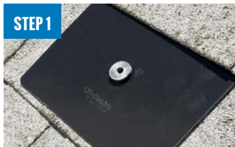
INSTALL FLASHKIT PRO FLASHING
