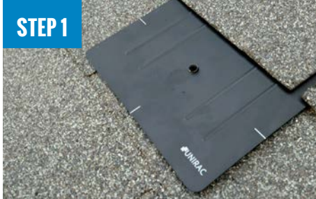
INSTALL FLASHKIT PRO FLASHING
